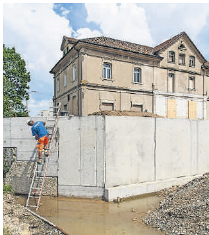
Bereits steht eine Wand, die den Platz beim künftigen Restaurant von der Treppe zur Aare abgrenzt. HP. BÄRTSCHI
